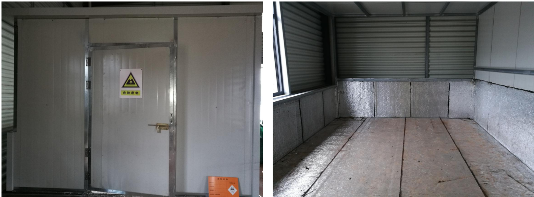
图 4-9 危险废物暂存库
