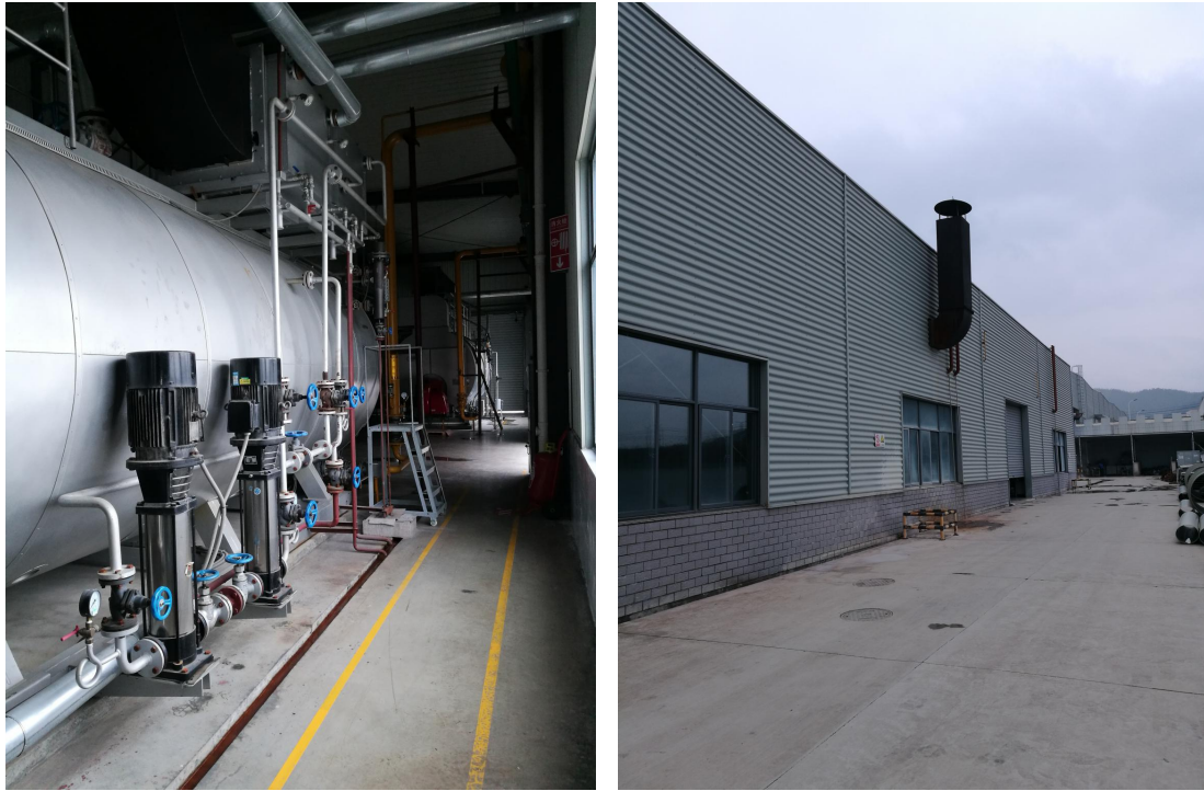
图 4-8 天然气锅炉废气
