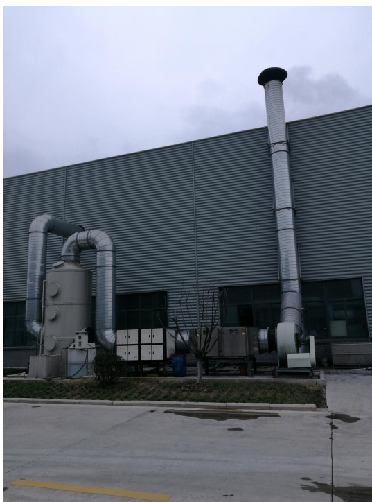
图 4-5 二道硫化废气处理设施
